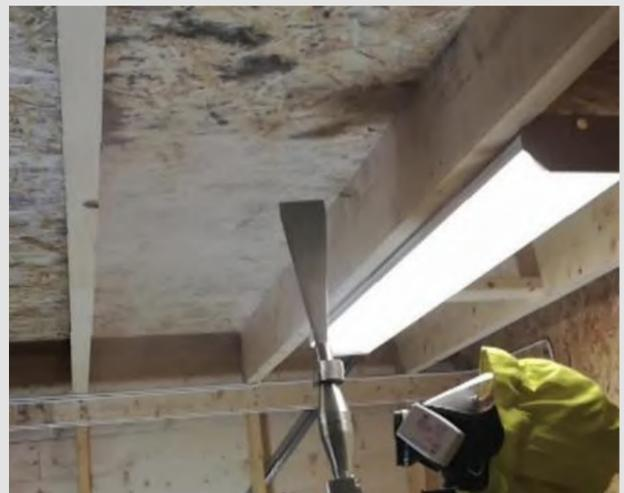
Trockeneisstrahlen entfernt die Stoffe, die das Schimmelpilzwachstum begünstigen können, sowie den vorhandenen Schimmel mit Hilfe von Trockeneispellets - 78 °C Gefrieretemperatur.
