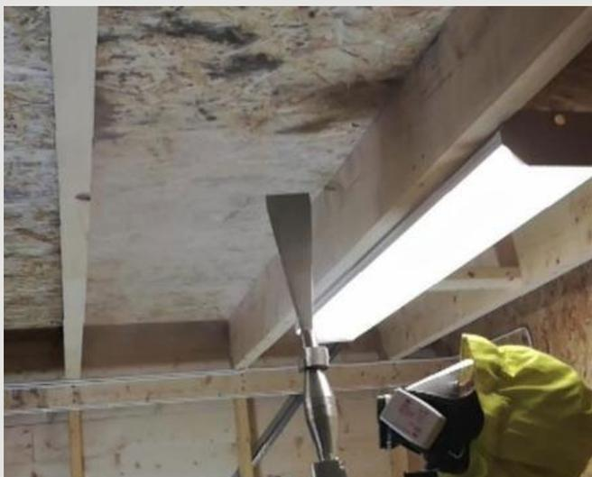
La limpieza con hielo seco elimina la materia que puede promover el crecimiento de moho junto con la eliminación del moho existente con la proyección a alta presión a temperaturas de congelación de  $-79^{\circ}\text{C}$ .
